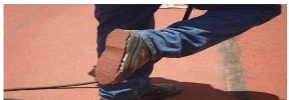
En los traslapos, para mayor seguridad, es conveniente que fluya el asfalto caliente, saliendo aproximadamente 1 cm. Para proteger el asfalto del borde, estando este completamente caliente, hacer riego de gravilla y presionarla para que se adhiera.
