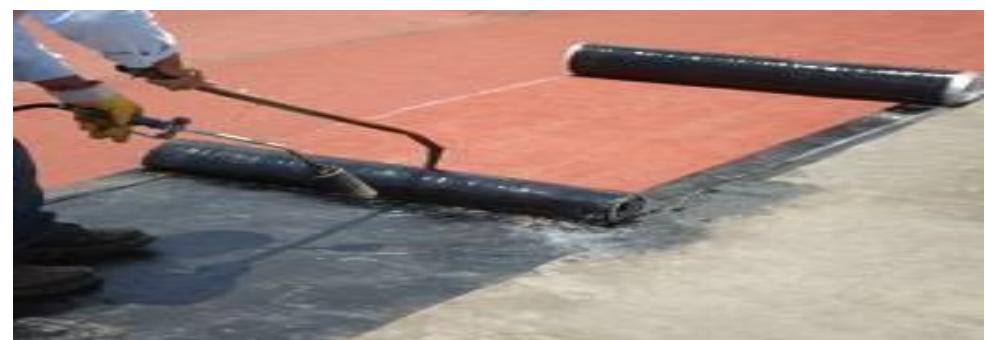
Continuando con la instalación, caliente por medio de soplete de gas (especial para prefabricados), la cara inferior de una sección del manto hasta fundir la película de polietileno que trae integrada, y desenrollelo presionando ligeramente a efecto de que suelde por vulcanización. Repetir esta operación a medida que va extendiendo el rollo de Festermip SBS FV Gravilla.
